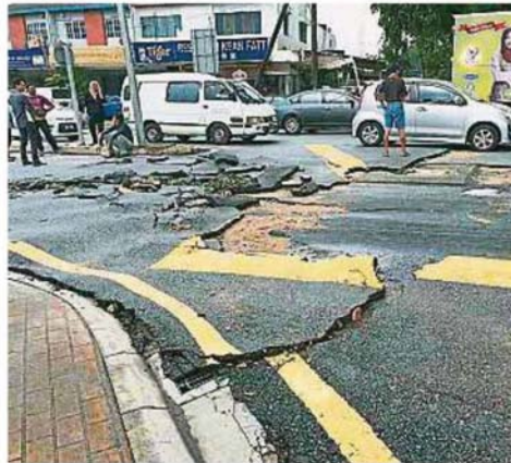
经八打灵再也市政厅工程师检查后，证实只是沥青路面裂开，并没有影响道路结构。
